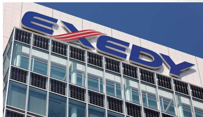
南側外壁に設置された太陽光発電パネル
